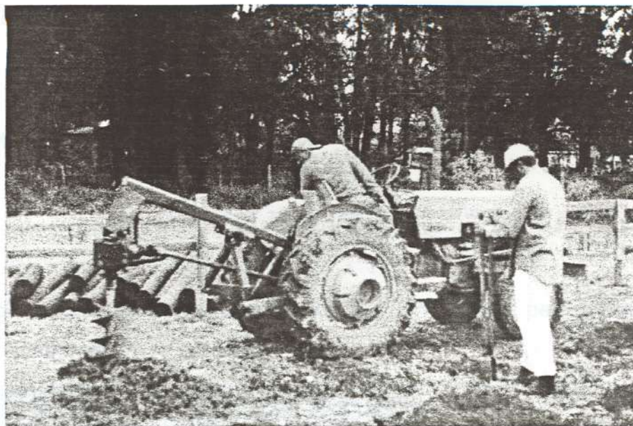
Foto 05 - Furação do Terreno
