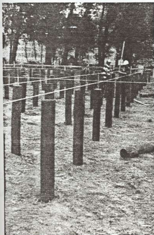
Foto 06 - Alinhamento das estacas
